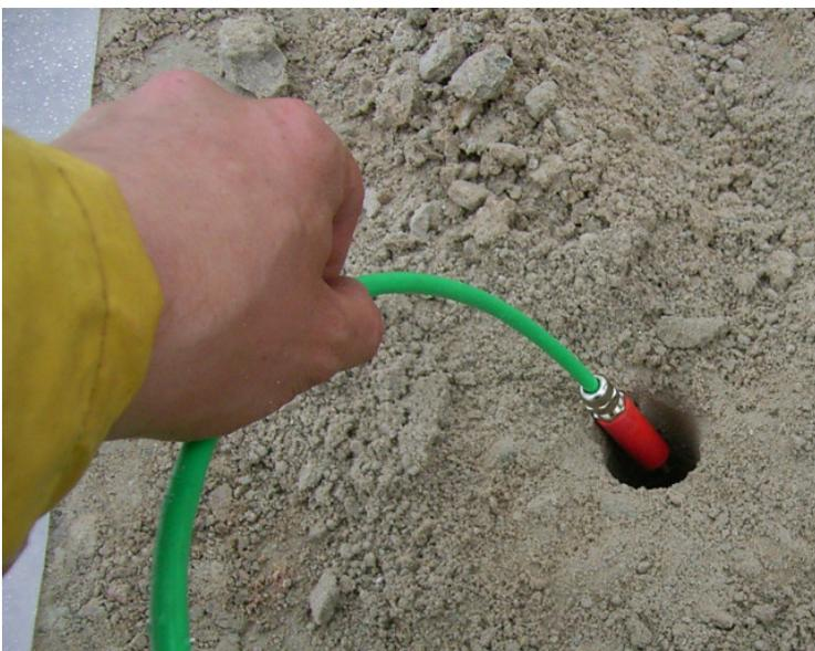
Für die wissenschaftliche Untersuchung werden Temperaturfühler im Erdreich unter der Bodenplatte eingebaut
