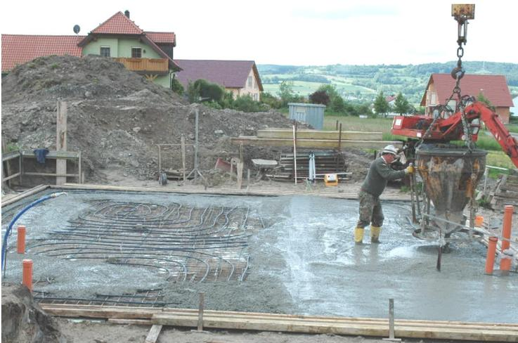
Soleregister (schwarzer Schlauch); Verlegung in der Sauberkeitsschicht unter der Sohlplattendämmung (Foto: Houwen)
